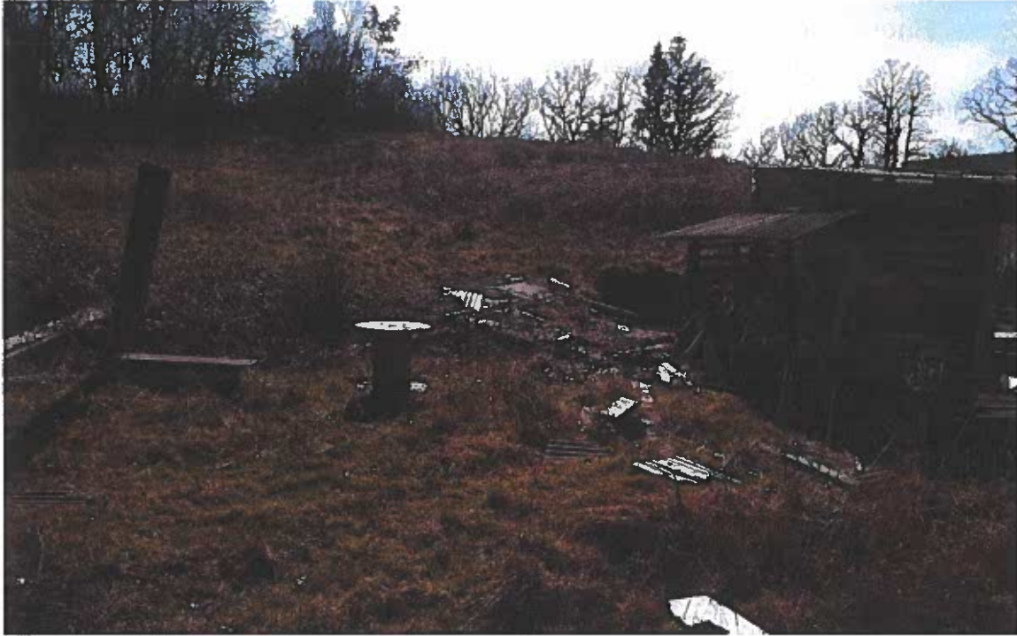
Abb. 6: zerfallende Gartenlaube zentral im Plangebiet
