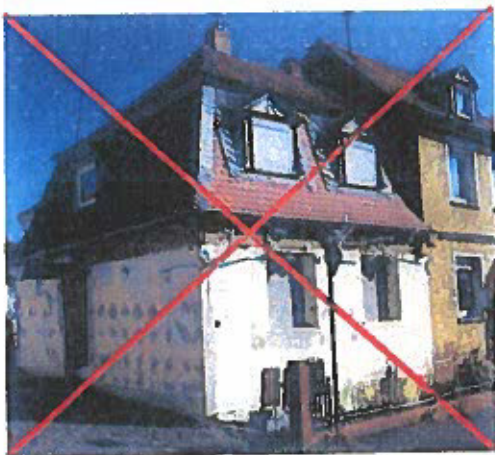
Unpassende Wärmedämmung an historischem Gebäude
