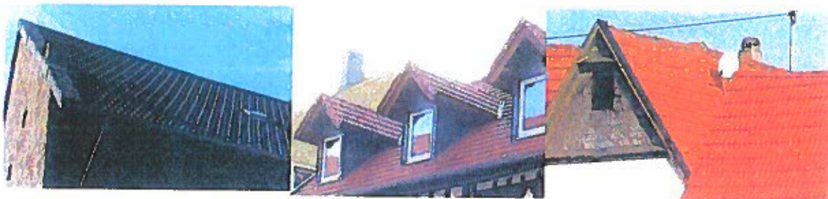
Braune, rotbraune bis rote Dacheindeckungen und .....
